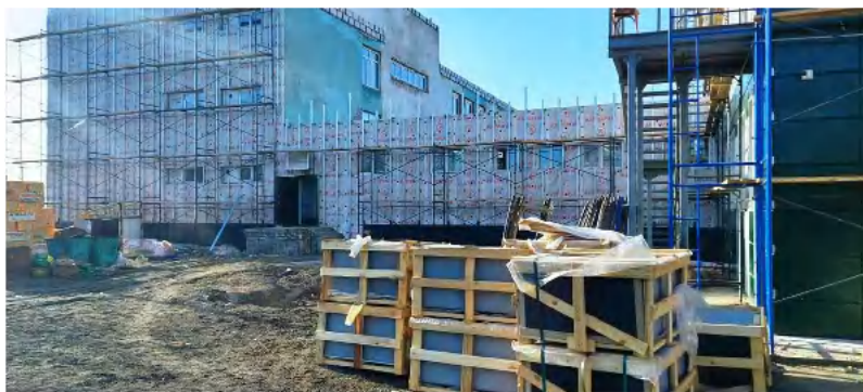
Ремонтные работы в школах
